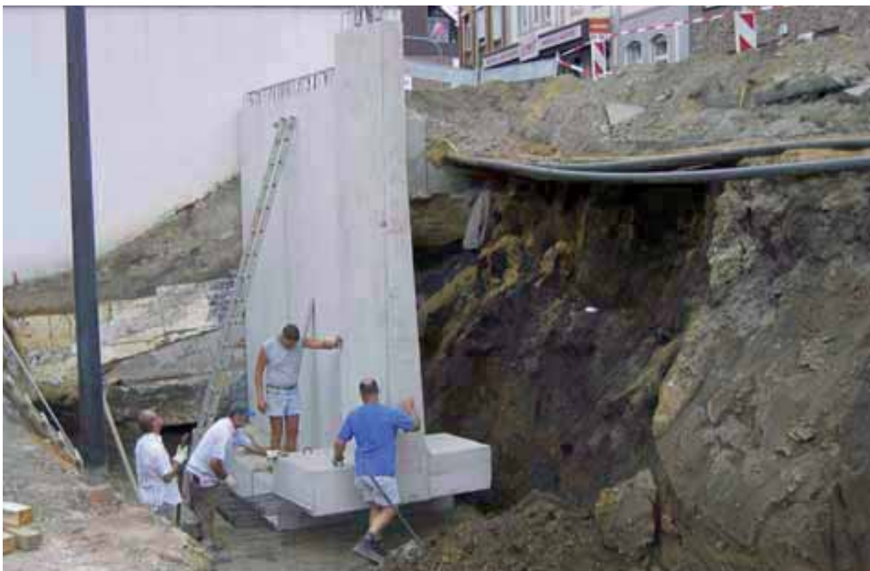
Mauerwinkel mit SPORN und Anschlussbewehrung – einfache Montage auch auf engstem Raum –
