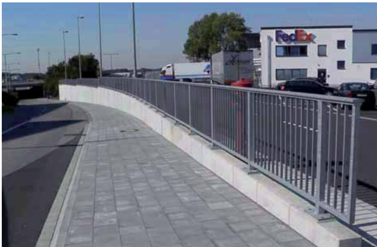
Mauerwinkel mit nachträglich montiertem Geländer
