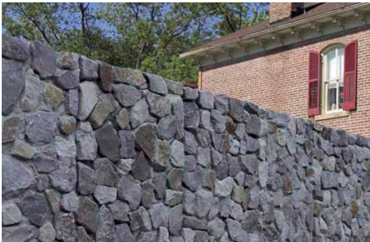
NATURSTEIN-Mauerwinkel Karbon-Quarzit vor einer Villa
