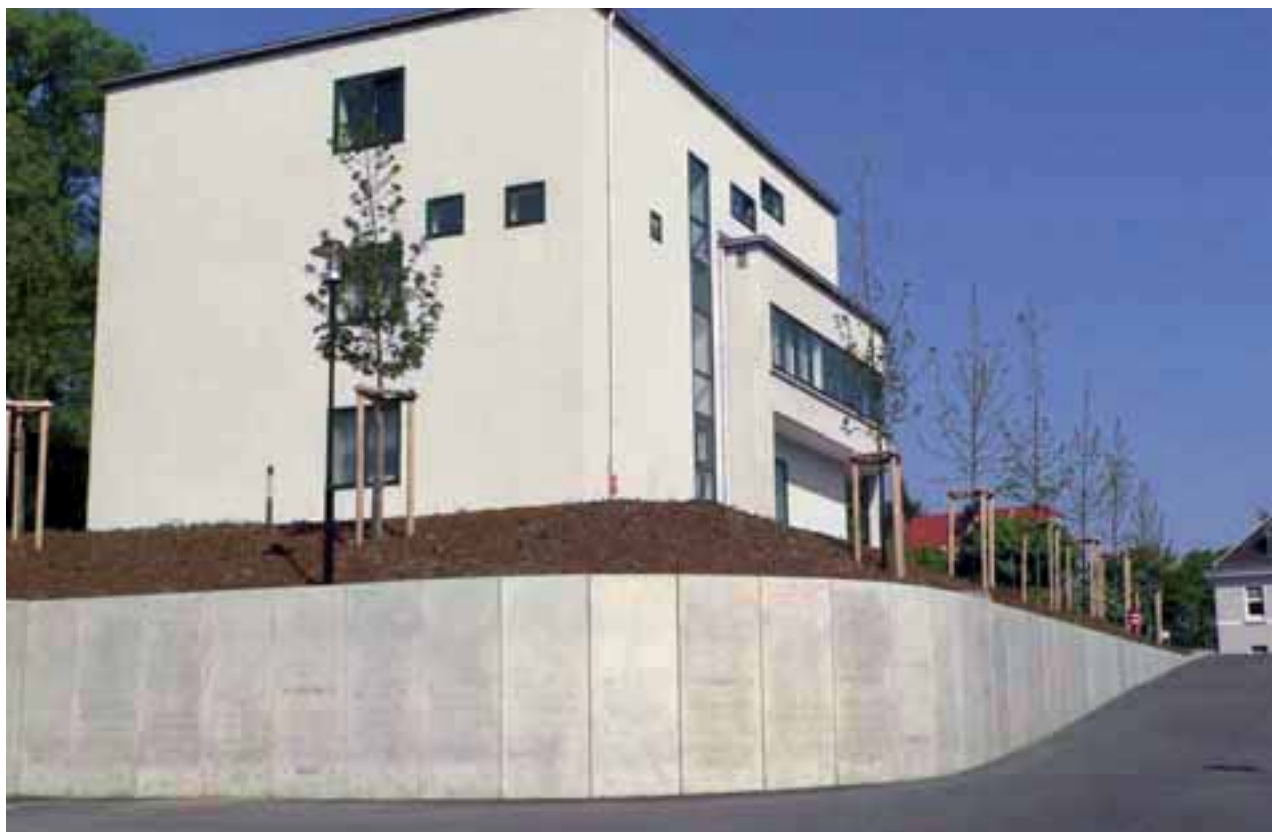
Mauerwinkel zum Abstützen eines Gebäudes – im Bogen versetzt –
