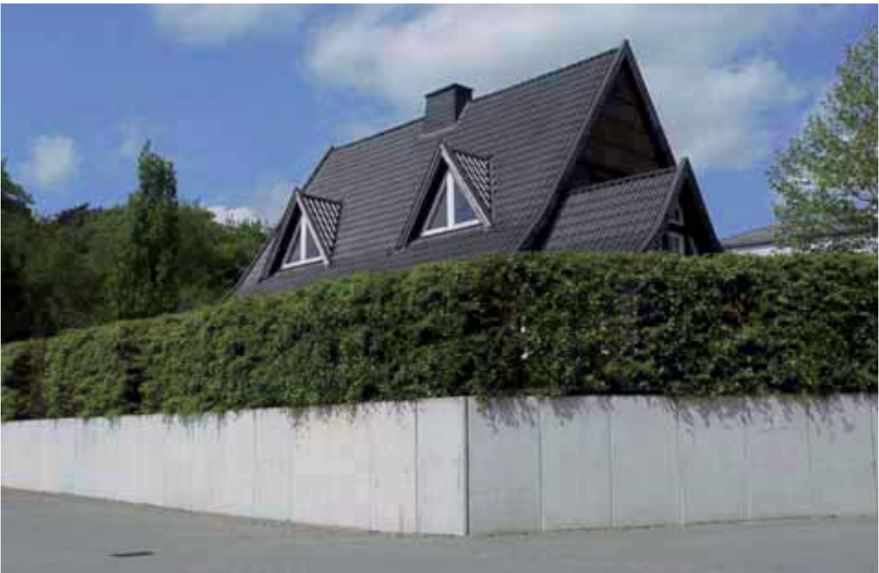
Stützwand mit Bepflanzung als Sichtschutz
