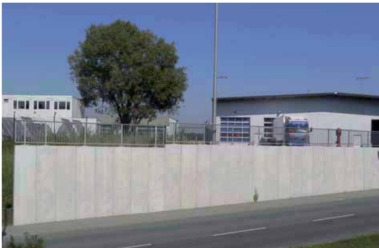
Mauerwinkel als Begrenzung eines Firmengeländes – regelmäßige hohe Lasten durch Schwerlastverkehr können die Stabilität nicht beeinträchtigen –
