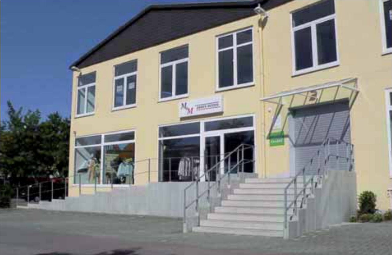
Treppenanlage mit abgetrepter Stützwand
