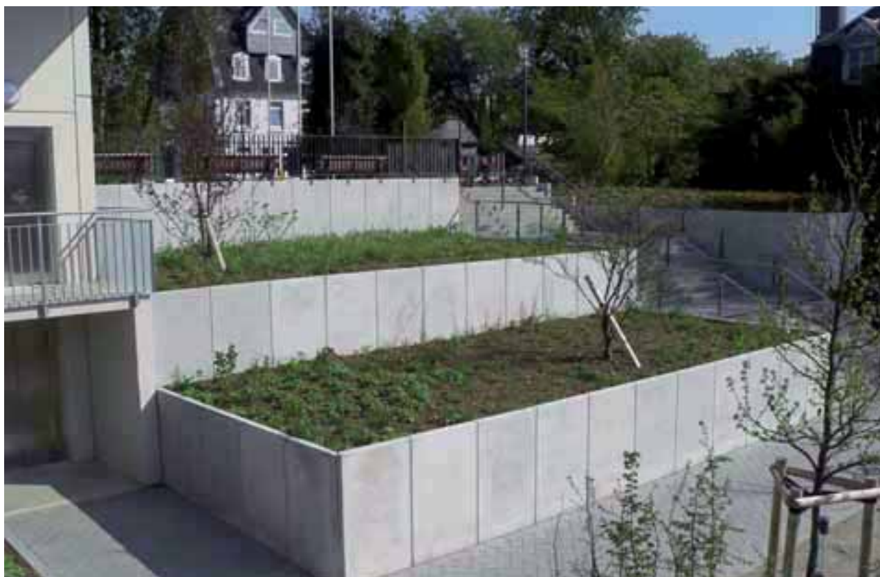
Terassenförmige Anordnung von Mauerwinkeln
